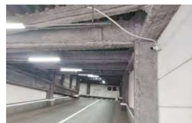
1階駐車場の出入口付近
